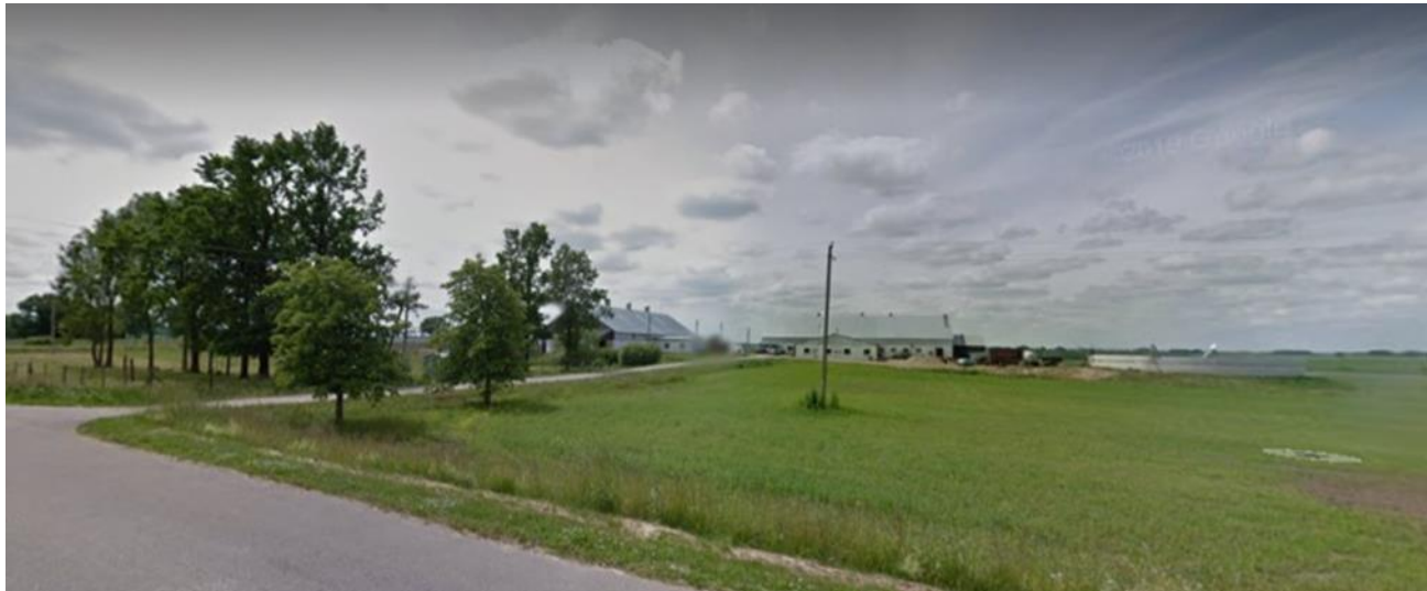
1 pav. L. Janušausko galvijų ūkis: esama ferma su skysto mėšlo rezervuaru, Laiškalnio k. 1, Šaukėnų sen., Kelmės r. sav.
