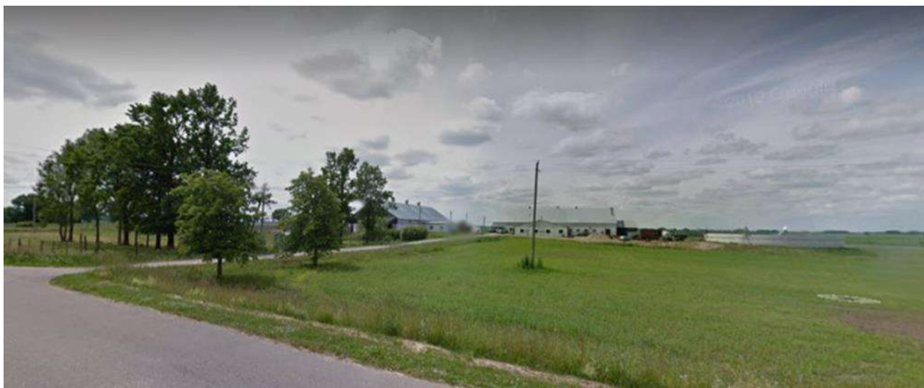
1. pav. L. Janušausko galvijų ūkis: esama ferma su skysto mėšlo rezervuaru, Laiškalnio k. 1, Šaukėnų sen., Kelmės r. sav.
